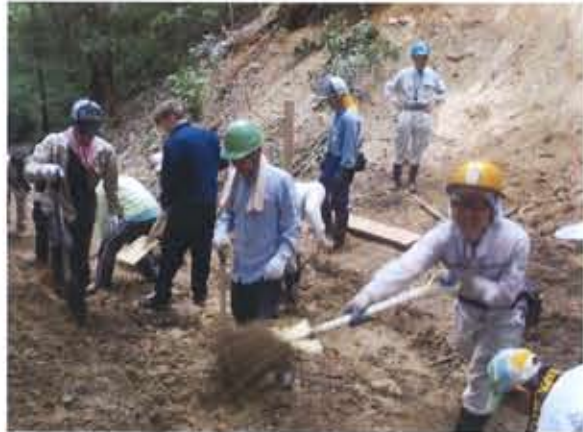
林道の補修作業に汗を流すメンバー
